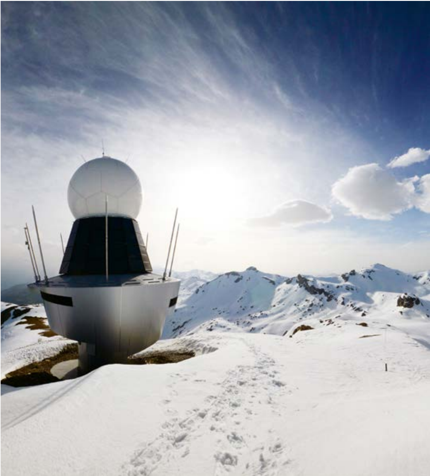
Radarstation Pointe de la Plaine Morte auf 2942 m ü.M. Das Wetterradar ist seit 2014 in Betrieb.
